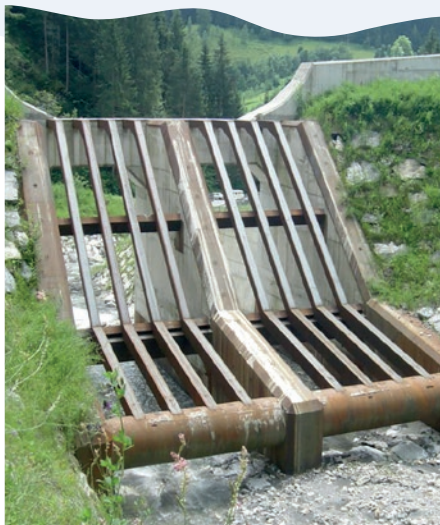
Schutzbauwerk in einem Wildbach
